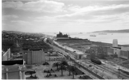
Fig. 1. Vue d'ensemble des travaux de la zone de Belém en vue de l'exposition du Monde portugais (1939) 7 .
